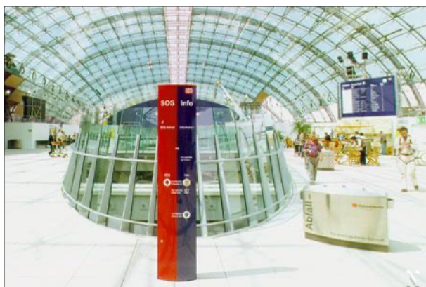
NIS 97-2 ICE station, Frankfurt am Main, Deutsche Bahn AG (German Rail)
